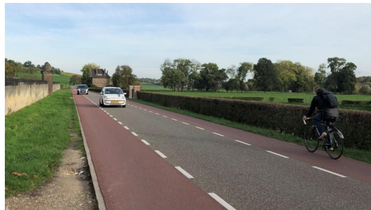
Voie centrale banalisée avec accotements en résine
